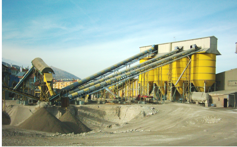
Şekil 9. Pomza ve çimento silolarından kesit bir görünüm.
